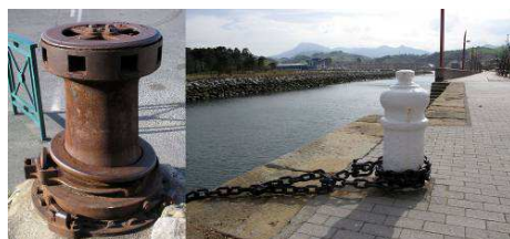
Fig. 11. Viejo cabestrante del puerto antiguo de Biarritz (a) y cañones colocados cumpliendo la función de bolardos (b), ría de Zumaia (fotografías realizadas en el trabajo de campo por parte del autor, entre 2010-2012).
