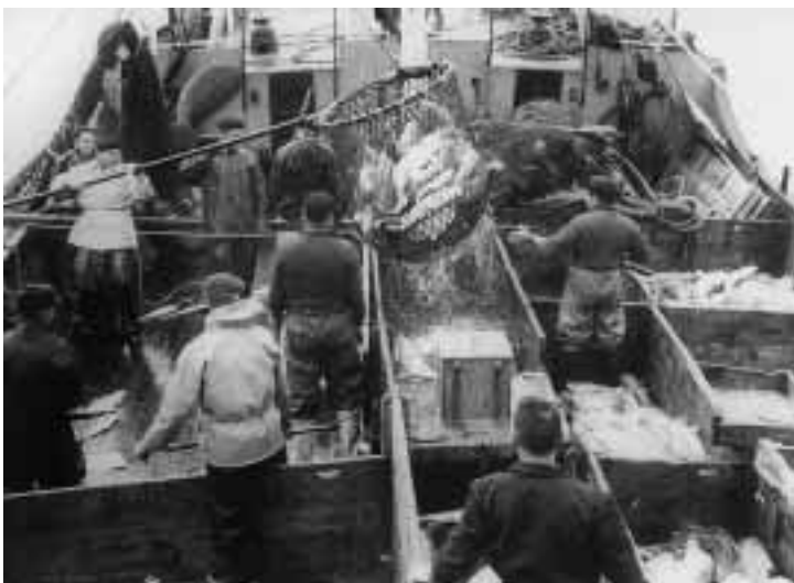
Izada de la red y utilización del salabardo en el Ignacio de Arrillaga de la casa armadora Ciriaco López y Cía. En la maniobra de embarque del bacalao, la red se iba vaciando con un gran salabardo accionado por una maquinilla hasta aligerar el volumen de pescado y proceder entonces al izado de todo el saco. El empleo de buques ramperos, que mediante mecanismos hidráulicos embarcaban toda la echada de una sola vez, simplificó esta tarea. Archivo Untzi Museoa.
